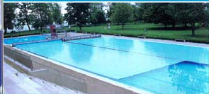
OLYMPIA mit Mehrschichtfolie, absenkbar in Trockenschacht
